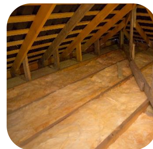
Typische Dämmung der obersten Geschossdecke Foto: Елена Труфанова - stock.adobe.com
