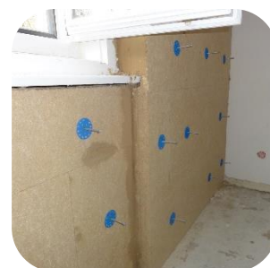
Beispielhafte Innendämmung, die bereits in einer der Wohnungen Ihrer WEG durchgeführt wurde. Foto: ifeu, 2023
